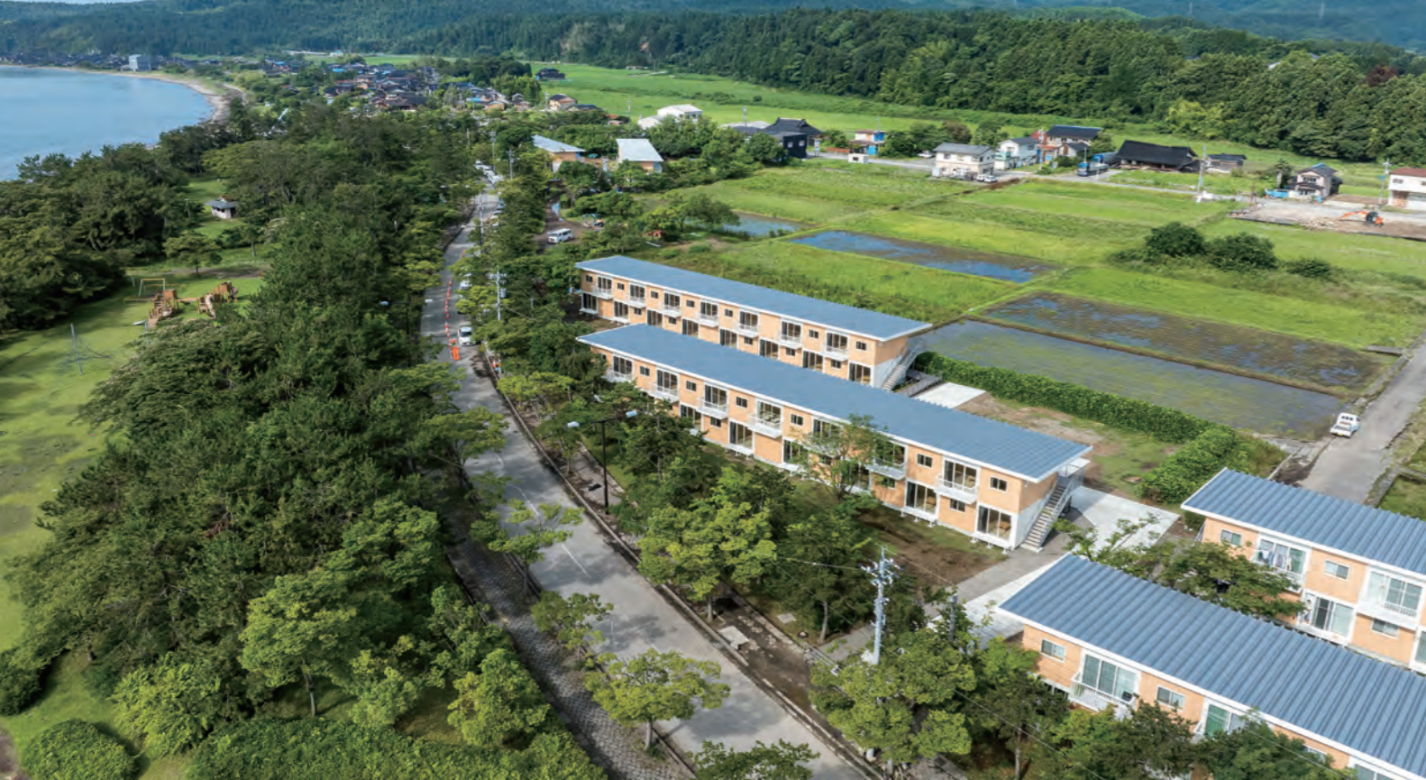
DLT 木造仮設住宅（珠洲） 設計：坂茂建築設計 施工：株式会社 家元
